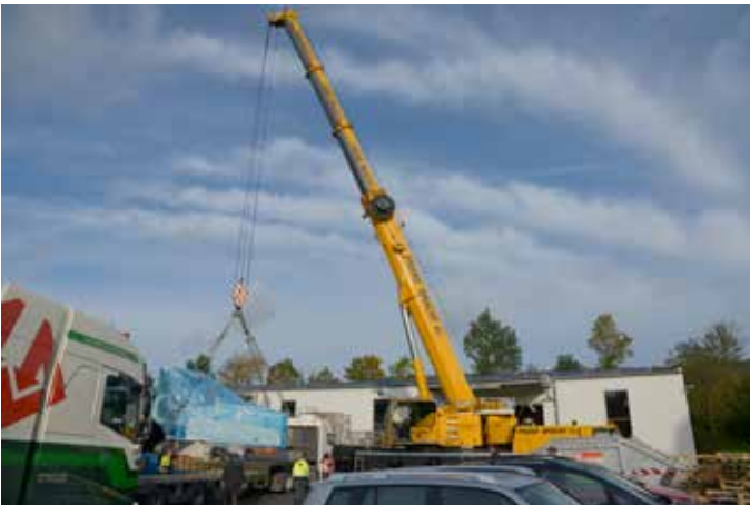
BU TZP-1: Schweres Gerät: Abladen der neuen Tiefziepresse mittels Autokran. Fotoquelle: Keinhorst GmbH
