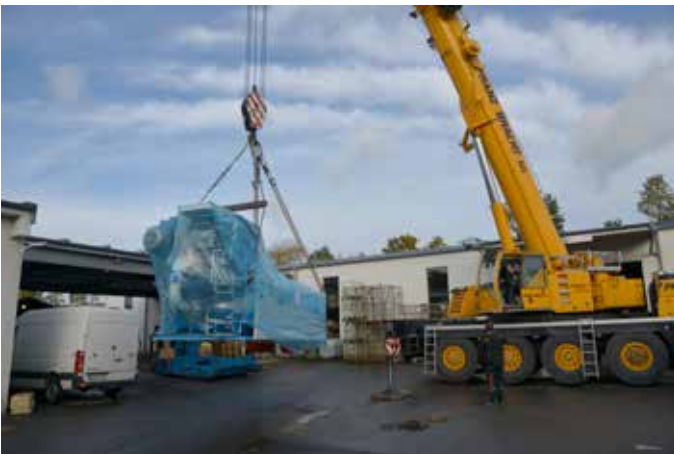
BU TZP-2: Nahezu 30 Tonnen hängen am Haken und sind bereit für die Montage in der Keinhorst-Maschinenhalle. Fotoquelle: Keinhorst GmbH
